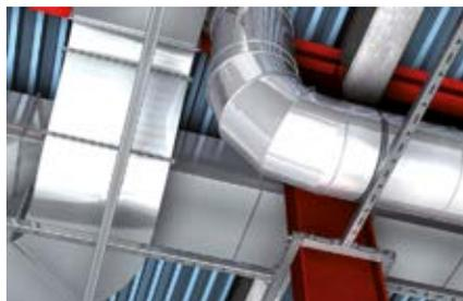
Опорная конструкция для крепления вентиляции
